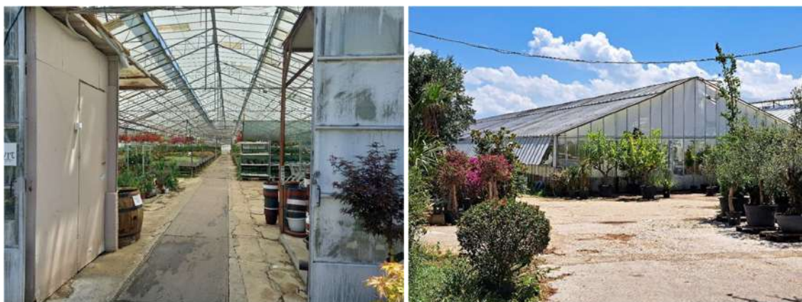
Slika 9. Postojeći zgrada B (staklenik) predviđen za rekonstrukciju
