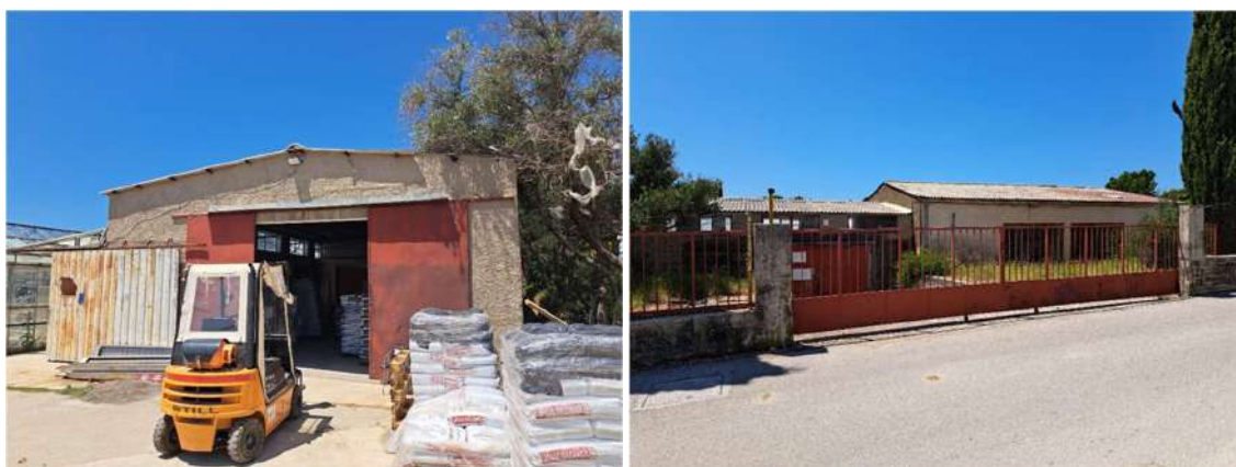
Slika 10. Postojeće zgrade C i E planirane za rekonstrukciju (buduća zgrada C)
